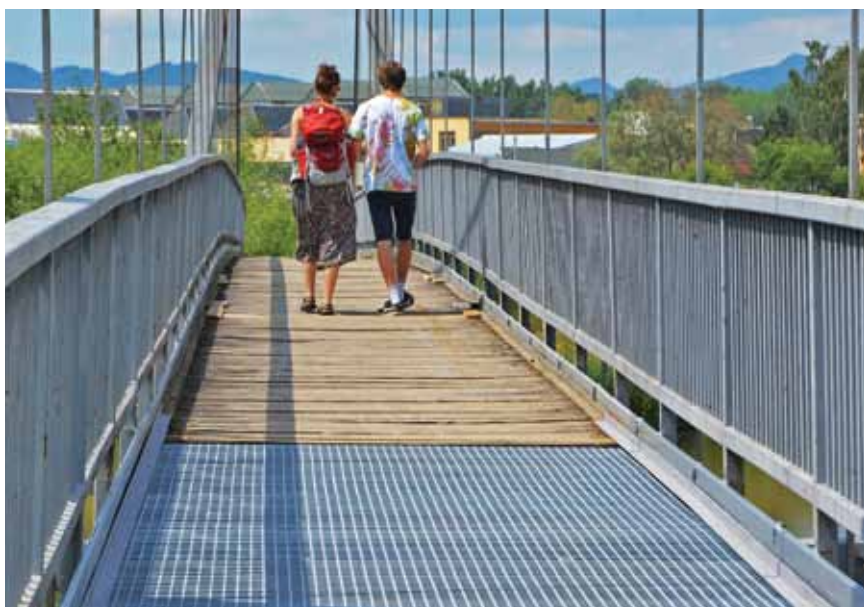
Lávka cez rieku Poprad - rekonštrukcia podlahy a náter konštrukcií, 18 784 €
