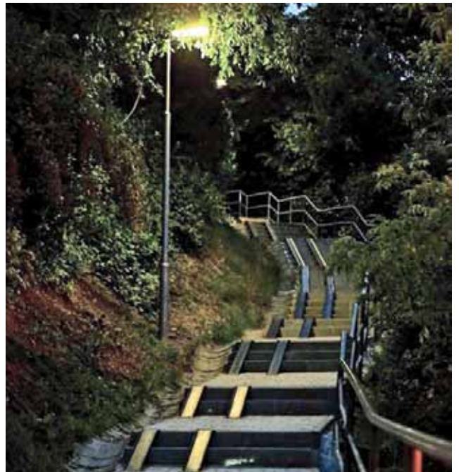
Rekonštrukcia schodiska: Východ - Levočská ulica, 18 000 €
