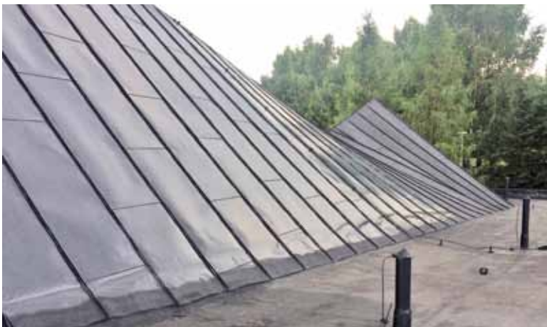
Modernizácia Domu smútku (oprava strechy), 12 994 €
