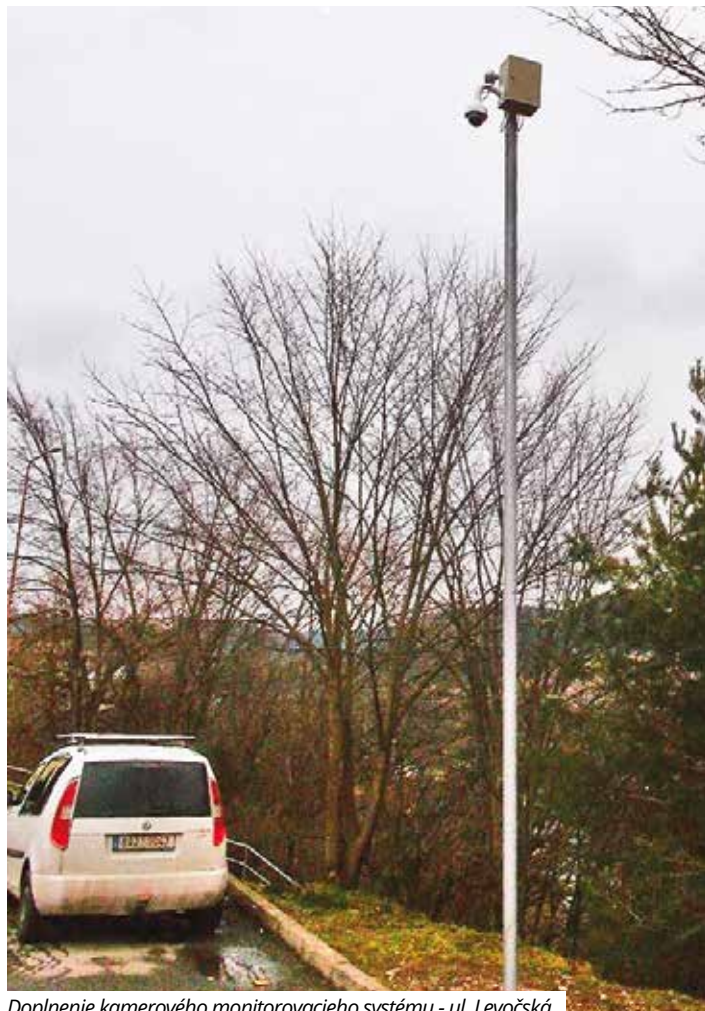
Doplnenie kamerového monitorovacieho systému - ul. Levočská
