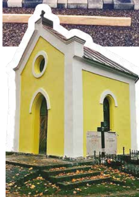
Rekonštrukcia chodníka a kaplnky - starý cintorín
