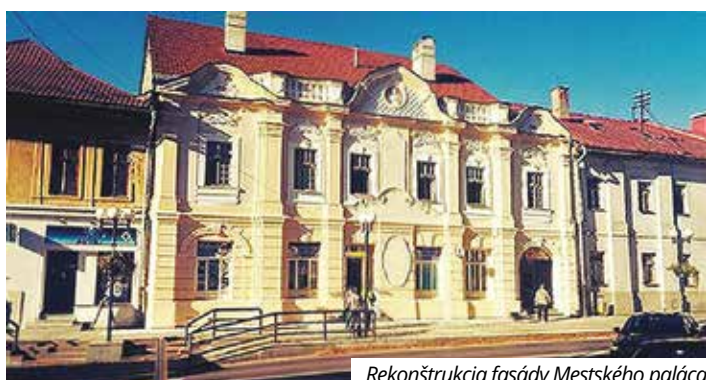
Rekonštrukcia fasády Mestského paláca
