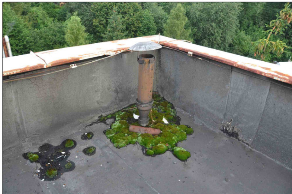
Výmena hydroizolačnej vrstvy a zateplenie plochej strechy objektu administratívnej budovy (starý stav)
