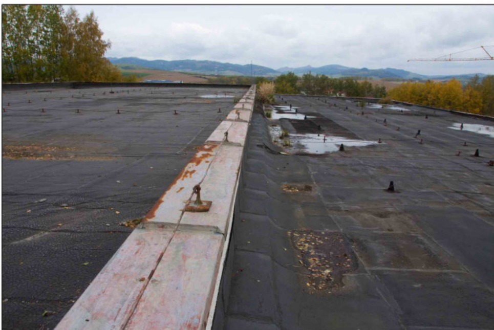
Výmena hydroizolačnej vrstvy na streche objektu kotolne K-4
