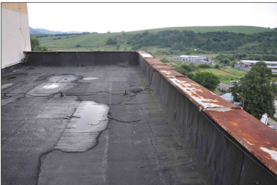
Výmena hydroizolačnej vrstvy a zateplenie plochej strechy objektu administratívnej budovy (starý stav)
