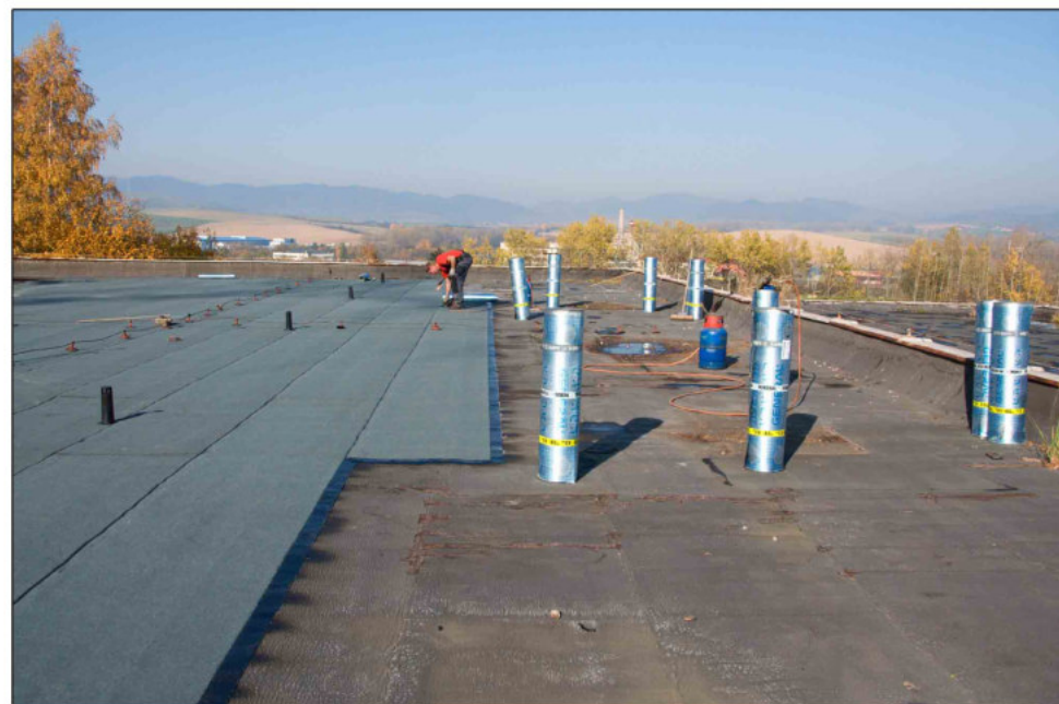
Výmena hydroizolačnej vrstvy na streche objektu kotolne K-4
