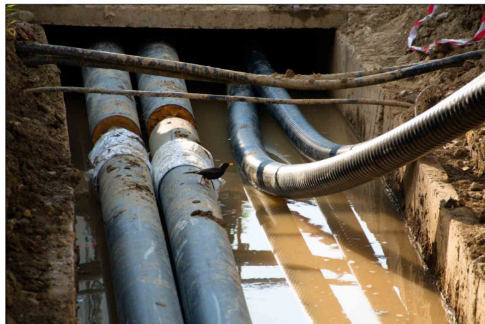
Výmena 100 m poškodeného teplovodného potrubia za potrubie predizolované v okruhu kotolne K-2
