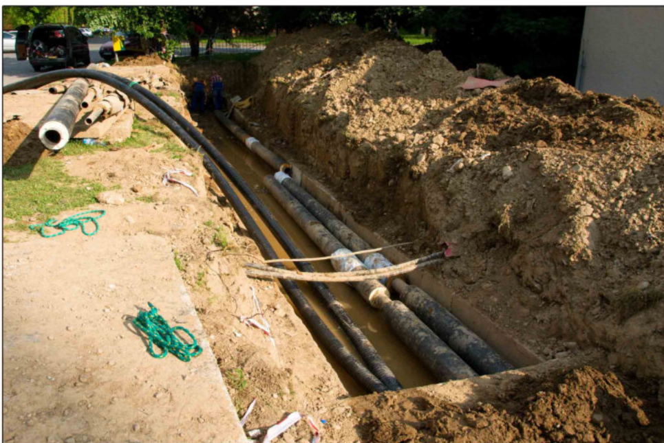
Výmena 100 m poškodeného teplovodného potrubia za potrubie predizolované v okruhu kotolne K-2
