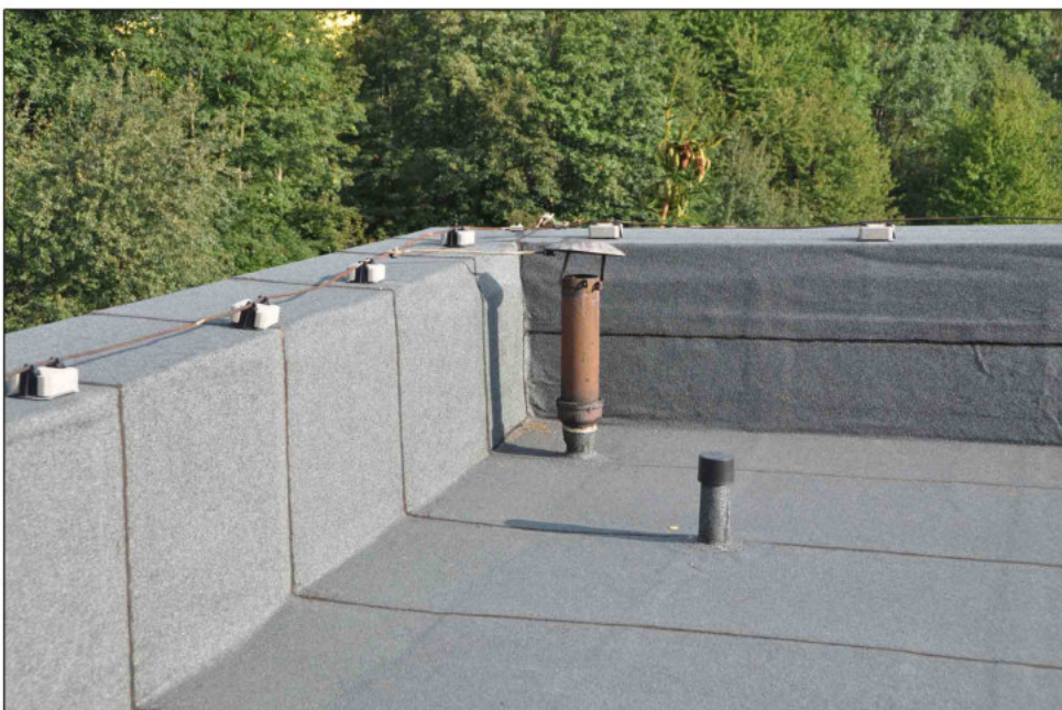
Výmena hydroizolačnej vrstvy a zateplenie plochej strechy objektu administratívnej budovy (nový stav)
